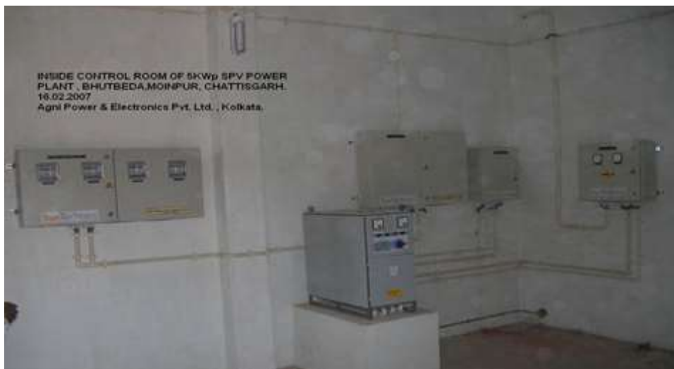
चित्र 9.2.4 इन्वर्टर और कंट्रोल इक्विपमेंट को एक कंट्रोल रूम में लगाया गया है
