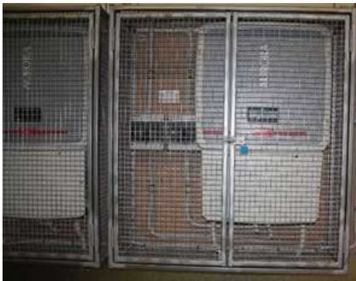
चित्र 9.2.3 इन्वर्टर तक पहुंच नियंत्रित है
