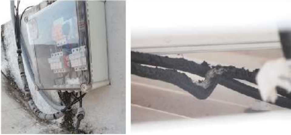
चित्र 9.3.3 खराब क्वालिटी के कन्ड्यूट और असुरक्षित केबल आसानी से क्षतिग्रस्त हो सकते हैं
