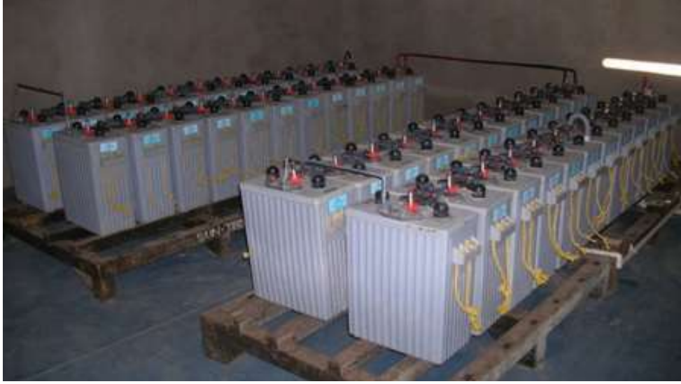
चित्र 9.2.5 अच्छे रोशनदान वाले कमरे में बैटरियों की अवस्थिति
