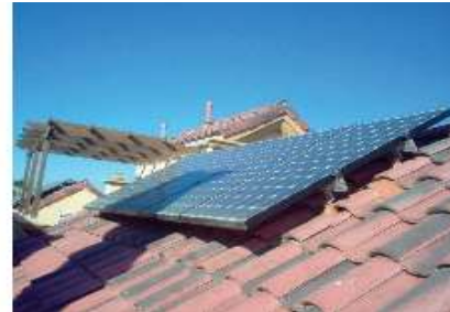
चित्र 9.3.1 कहीं-कहीं छाया पड़ने से संवेदनशील जगह पैदा होता है और मॉड्यूल को क्षति पहुंच सकती है
