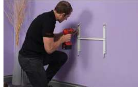
चित्र 8.2.6 इन्वर्टर माउंटिंग स्ट्रक्चर को इंस्टॉल करना
