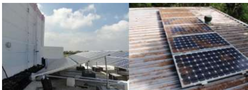
चित्र 9.2.2 एरे की इंस्टॉलेशन के लिए साइट का गलत चयन
