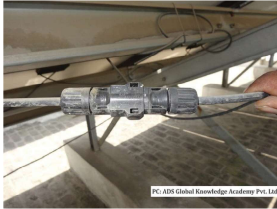
चित्र 8.5.4 MC4 कनेक्टर
