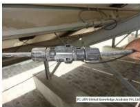
Fig. 8.3.1 Module interconnection
